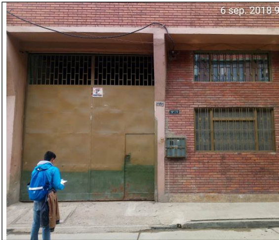
Foto No. 1 Fachada del establecimiento
